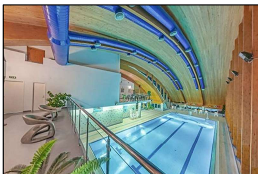
Рисунок 3 – Трехшарнирные арки. Спорткомплекс пансионата «Буран» в Сергиево-Посадском районе Московской области
