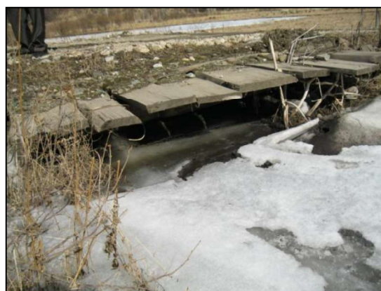
Рисунок 3 – Деревянная водопропускная труба, через которую осуществляется пропуск наледной воды
