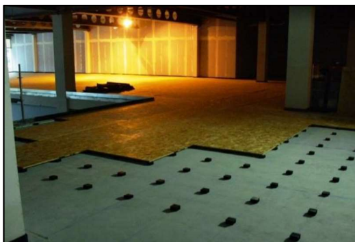
Рисунок 3 – Устройство «плавающего пола»
