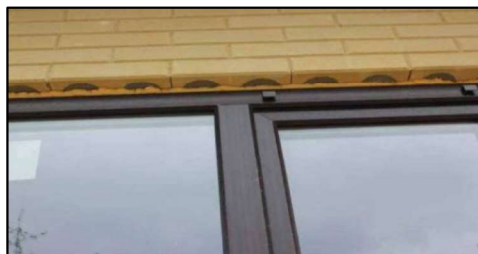
Рисунок 8 – Применение лего-кирпича над оконным проемом
