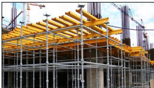
Рисунок 1 – Опалубка перекрытий балочно-рамная PSK-CUP
