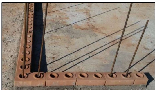
Рисунок 5 – Кладка первого ряда, наиболее важного при строительстве из данного материала
