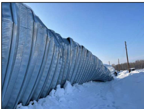
Рисунок 2 – При обрушении арочное покрытие получило одностороннее боковое перемещение
