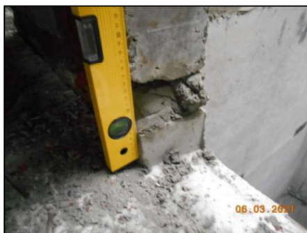
Рисунок 1 – 12 этаж. Толщина шва между лифтовыми шахтами по высоте составляет до 60 мм
