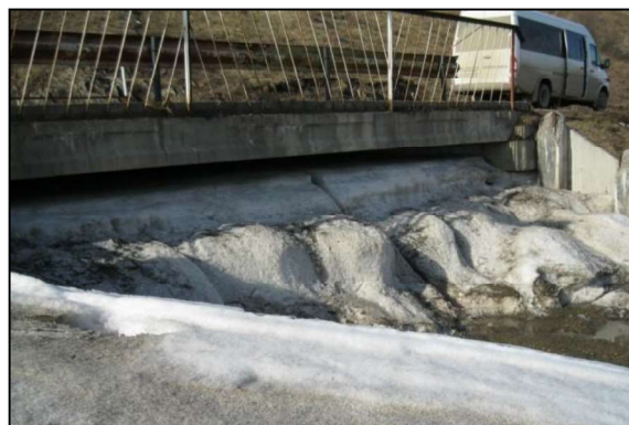
Рисунок 1 – Отверстие моста, заполненное речной наледью в Солонешенском районе Алтайского края
