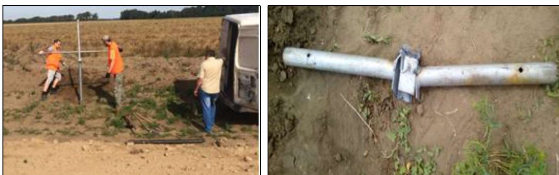
Рисунок 4 – Процесс закручивания винтовой сваи вручную
