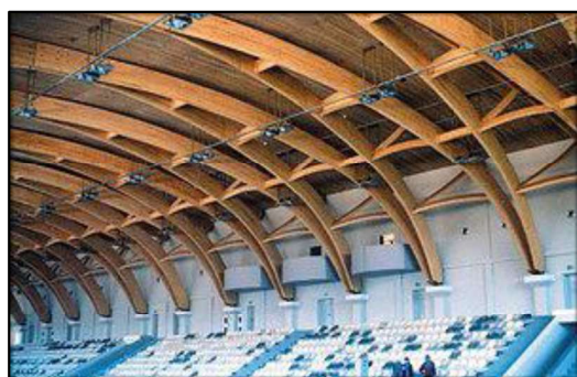
Рисунок 4 – Пересекающиеся арки пролетом 42 м. Спортивный манеж «Подмосковье» в г. Щелково Московской области
