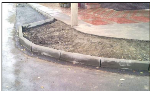
Рисунок 4 – Смонтированный бортовой камень с нарушением допусков
