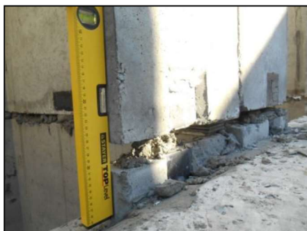
Рисунок 3 – Неравномерное заполнение монтажного шва цементно-песчаным раствором (11 этаж). Отсутствие опорных пластин вблизи проема
