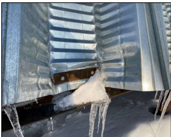
Рисунок 6 – Контакт оцинкованного металла с черным неокрашенным металлом создает гальваническую пару
