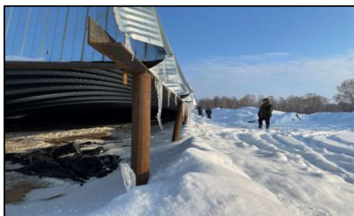
Рисунок 3 – Обвязочный уголок приварен угловыми сварными швами к стальным стойкам из трубы 108 × 4
