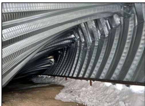
Рисунок 4 – Узел крепления арки к опорным уголкам
