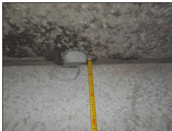
Рисунок 4 – 2 этаж. Толщина шва до 32 мм
