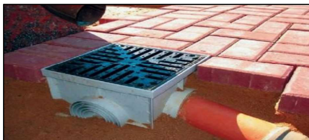
Рисунок 3 – Дождеприёмники под водосточными трубами зданий для отвода дождевых вод
