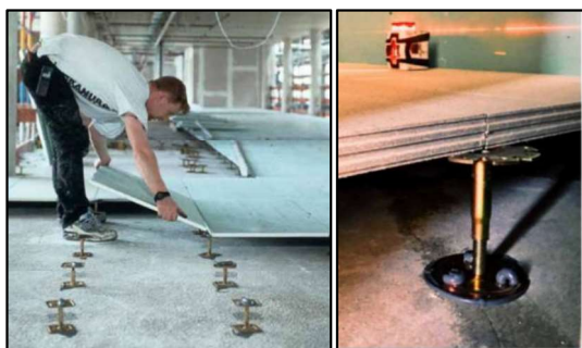
Рисунок 4 – Устройство неразъёмного фальшпола
