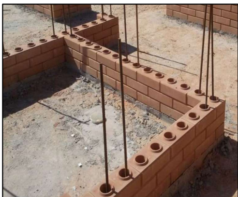
Рисунок 4 – Строительство здания с применением лего-кирпичей
