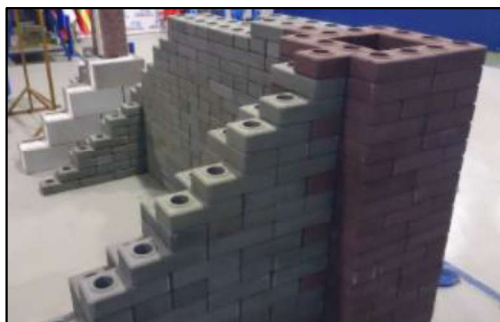
Рисунок 3 — Возведение стены из леги-кирпича, которое демонстрирует кладку
