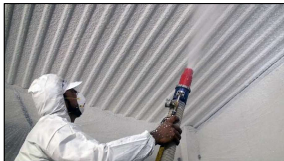
Рисунок 6 — Работы по выполнению напыляемого покрытия Sonaspray K13
