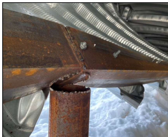
Рисунок 5 – Разрушение обвязочного уголка и сварного шва, прикрепляющего уголок к стойкам
