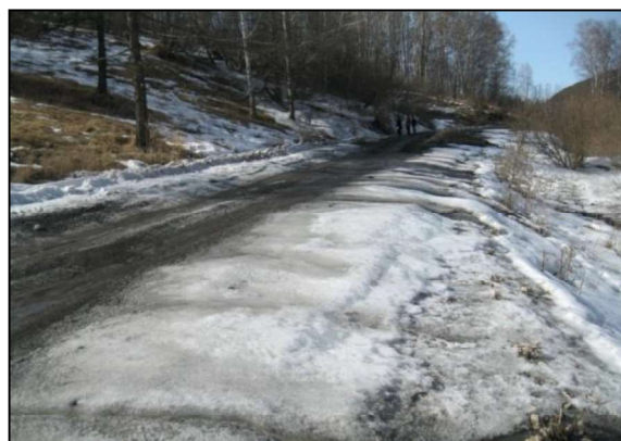
Рисунок 2 – Образование наледи на автомобильной дороге «Быканов мост – Солоновка – Солонешное – граница Республики Алтай»
