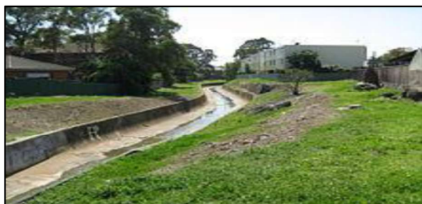
Рисунок 5 – Дождевая ливнесточная канализация открытого типа
