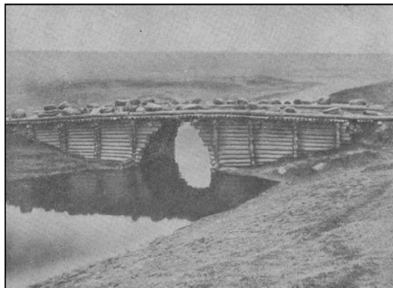
Рисунок 1 – Консольно – балочный мост с арочным пролетом на р. Сие Архангельской обл. (снимок 1920 г. Фототека ГНИМА им. Щусева)
