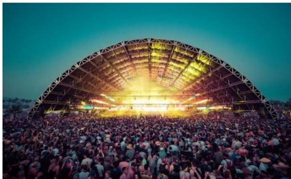
Рисунок 9 - Сцена для электронной музыки с навесом из алюминиевых ферм
