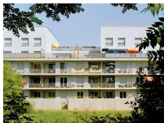
Рисунок 3 - Частичное удаление верхних этажей создало ступенчатый объем с большими крышами (Фото:Stefan Forster Architekten)
