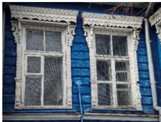
Рисунок 2 - Пример наличника на здании по адресу улица Ползунова д. 48
