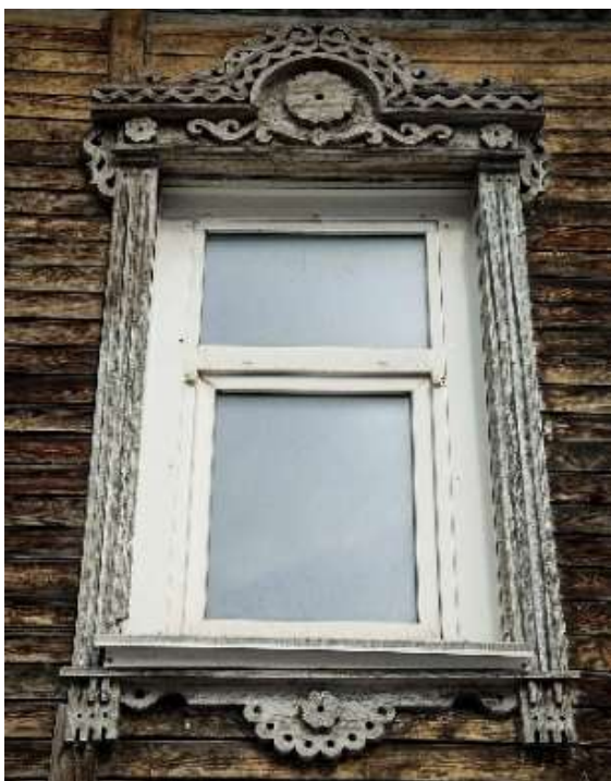
Рисунок 1 - Пример наличника на здании по адресу проспект Красноармейский д. 12
