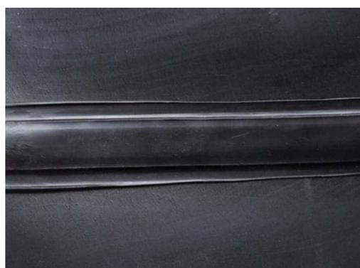
Рисунок 4 – Нахлесточное соединение мембраны толщиной 2 мм
