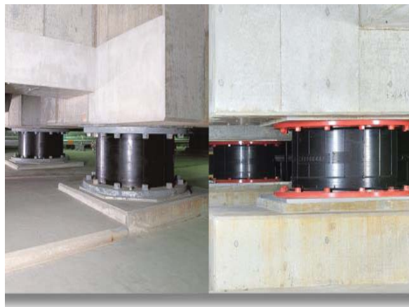
Рисунок 1 – Фундамент на подшипниках
