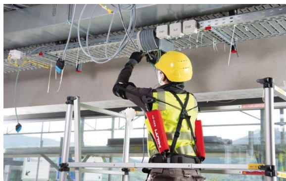
Рисунок 4 – Выполнение электромонтажных работ с помощью экзоскелета верхних конечностей
