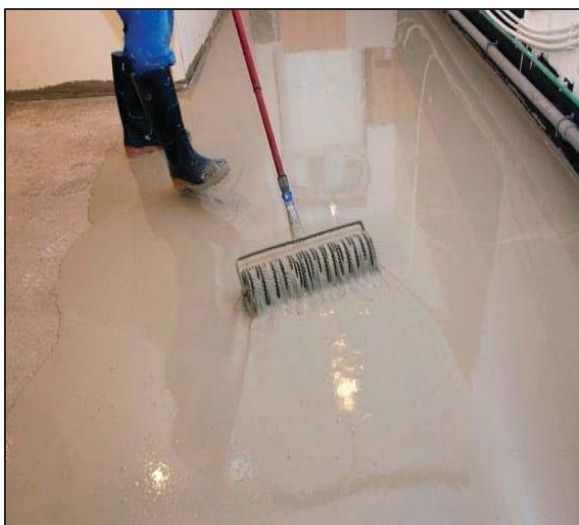
Рисунок 4 – Распределение состава наливного пола зубчатым шпателем
