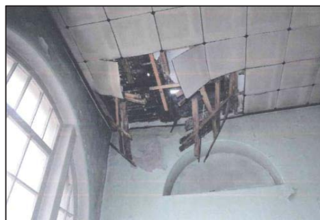
Рисунок 7 – Фрагмент чердачного перекрытия
