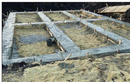
Рисунок 3 – Ленточный монолитный фундамент ФАПа типового решения
