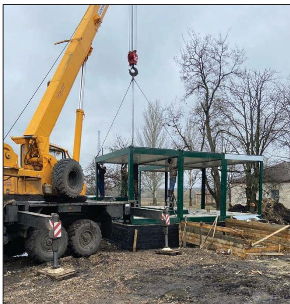
Рисунок 5 – Готовый блок-модуль каркаса ФАПа
