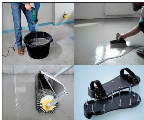
Рисунок 2 – Технологические операции при устройстве наливных полов
