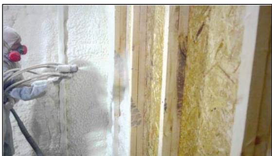
Рисунок 1 – Нанесение напыляемой теплоизоляции
