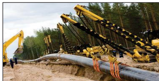
Рисунок 1 – Технология укладки крупногабаритных многосекционных трубопроводов кранами-трубоукладчиками
