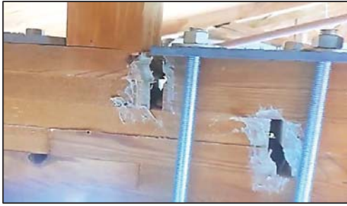
Рисунок 5 – Нижний пояс фермы. В четырех досках из шести вместо соединений на зубчатый шип – отверстия
