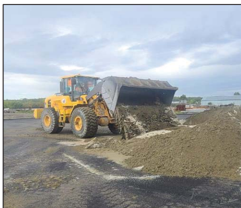
Рисунок 3 – Смешивание ПСС колесным трактором с ковшем
