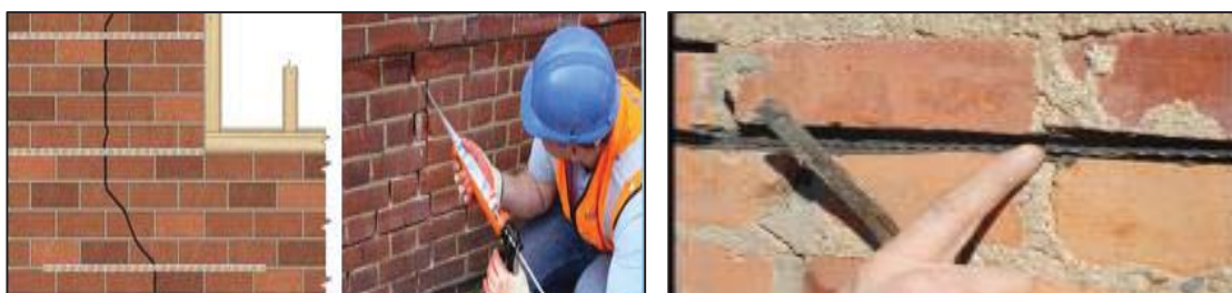
Рисунок 4 – Укладка винтовых стержней при ремонте трещин в кирпичной кладке
