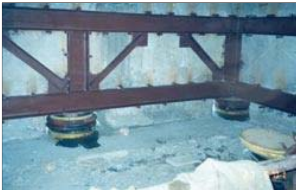
Рисунок 2 – Фрагмент размещения плоских гидродомкратов на задавленных трубобетонных сваях в подвале здания
