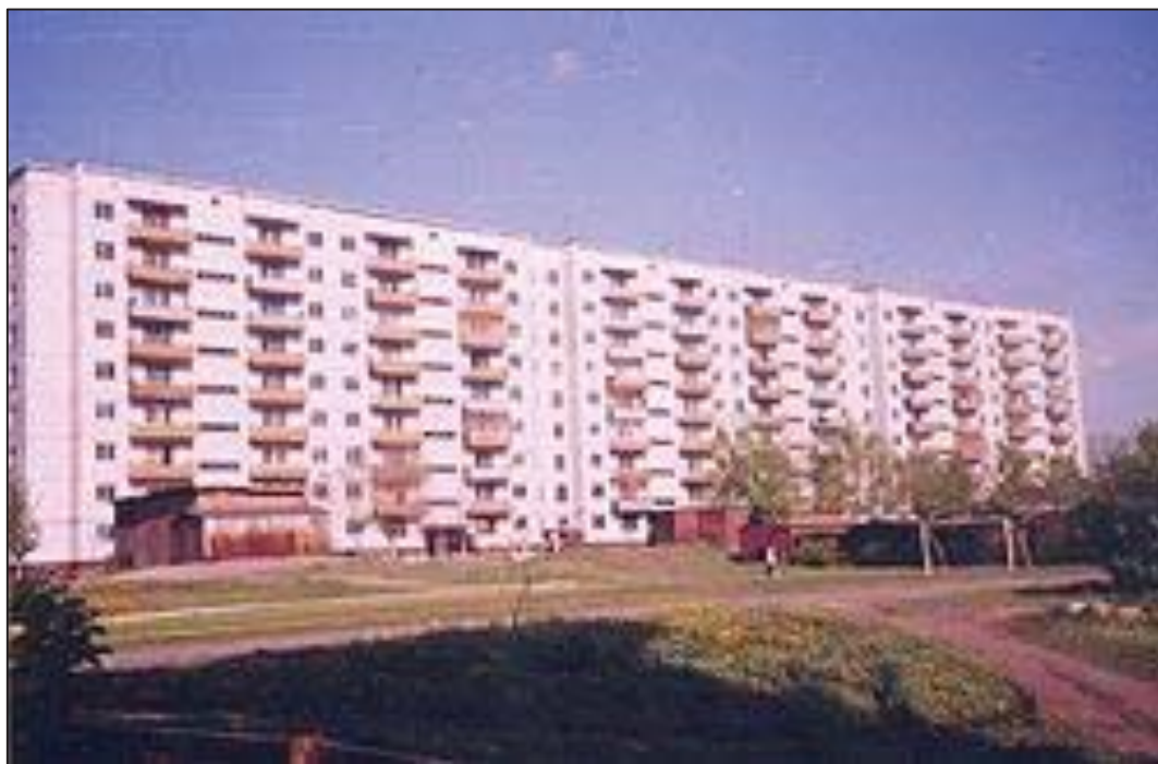
Рисунок 1 – 9-этажный крупнопанельный жилой дом на ул. Октябрьское шоссе, 63 г. Белово, Кемеровская область
