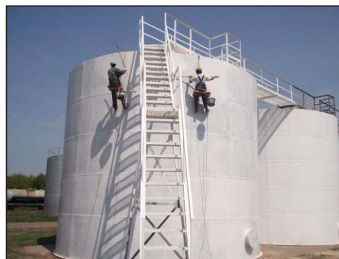
Рисунок 2 – Процесс нанесения защитного покрытия на один из вертикальных резервуаров на нефтебазе
