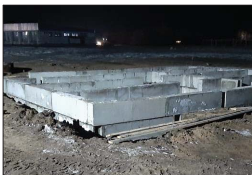
Рисунок 4 – Фундамент ФАПа из блоков ФБС
