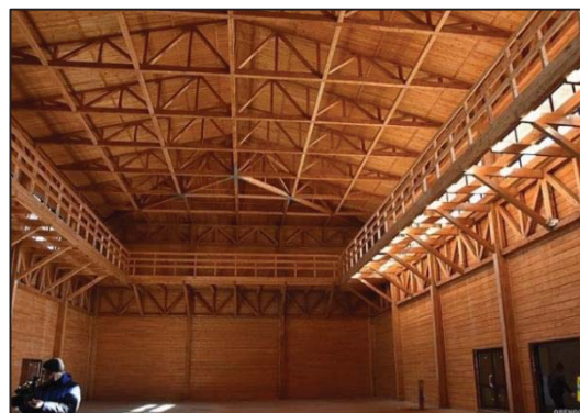
Рисунок 2 – Спортивный зал, перекрытый дощато-клееными фермами
