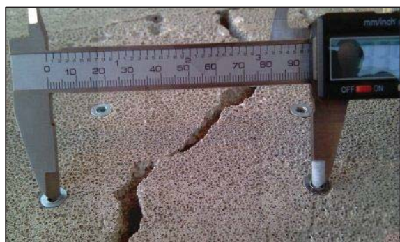
Рисунок 4 – Пример использования точечных маяков
