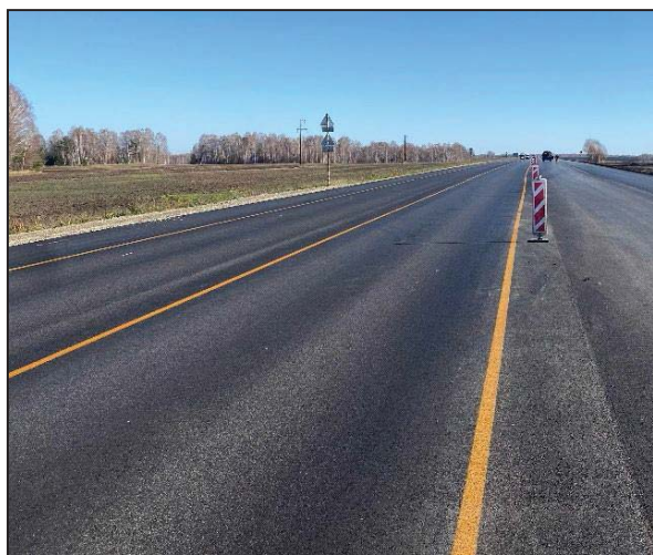
Рисунок 4 – Покрытие автомобильной дороги Р-256 «Чуйский тракт» на км 250+000 – км 258+00 после завершения работ по устройству дорожной одежды
