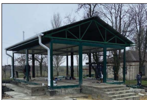
Рисунок 2 – Металлический каркас ФАПа типового решения
