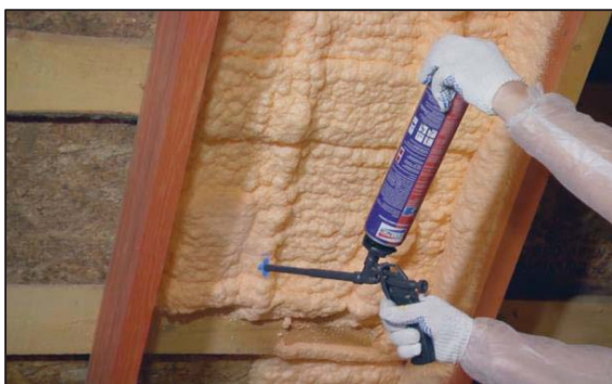
Рисунок 2 – Нанесение напыляемой теплоизоляции на чердачное перекрытие
