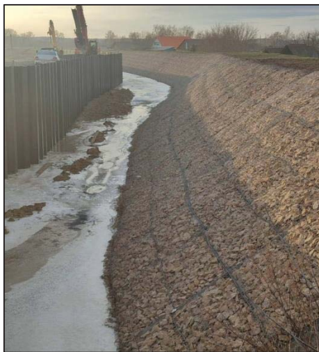
Рисунок 5 – Крепление откосов р. Землянка габийными конструкциями и стальным шпунтом
