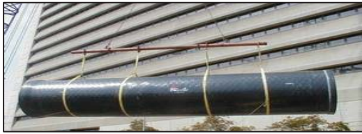
Рисунок 4 – Укладка трубопровода с помощью балочной траверсы и мягких стропов
