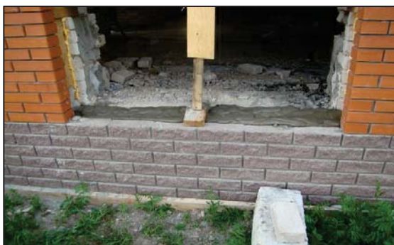
Рисунок 7 – Фрагмент фасада после заливки первого слоя пенобетона в стену
