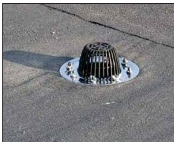
Рисунок 1 – Приемная воронка, установленная на плоской кровле
