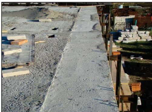
Рисунок 5 – Монолитный железобетонный пояс
