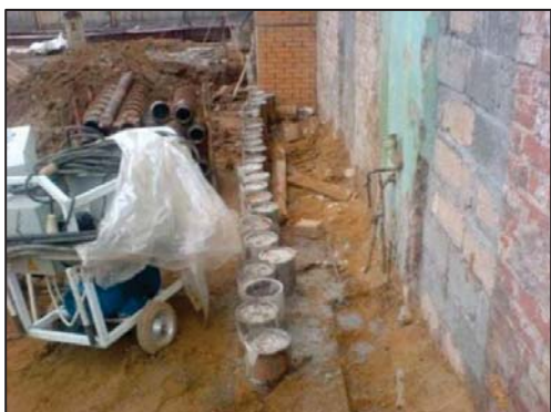
Рисунок 3 – Устройство отсечного экрана из металлических труб
