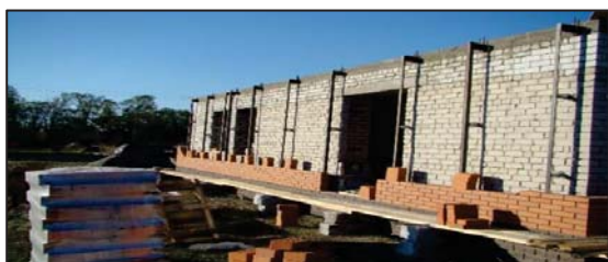
Рисунок 4 – Стена существующего здания – основа для устройства новой фасадной системы
