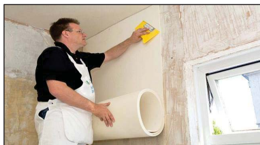
Рисунок 7 – Наклеивание полотен с аэрогелем на стены
