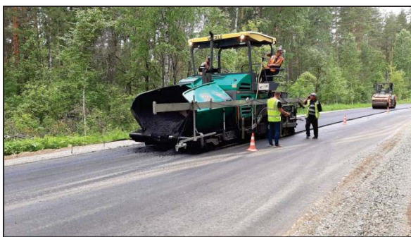
Рисунок 1 – Укладка холодной асфальтобетонной смеси для защитного слоя
