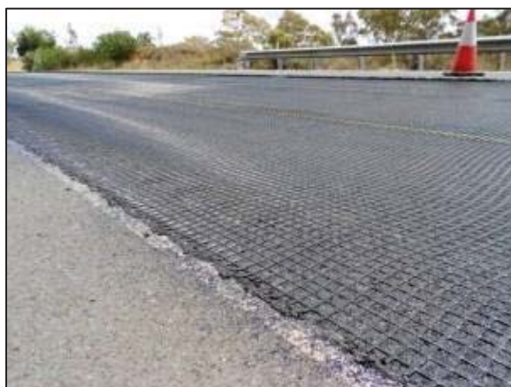
Рисунок 4 – Армирование асфальтобетона геосеткой
