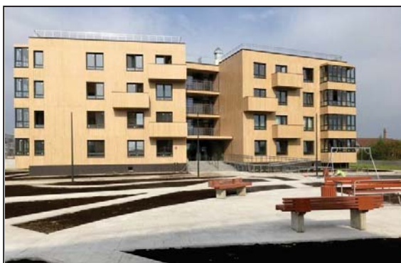
Рисунок 7 – Общий вид на жилой здание в г. Сокол Вологодской области
