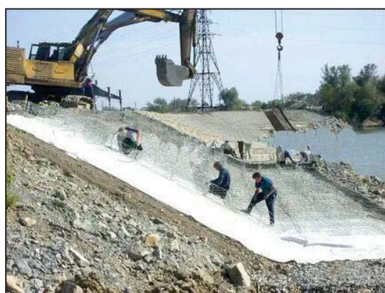
Рисунок 5 – Бетонирование склона
