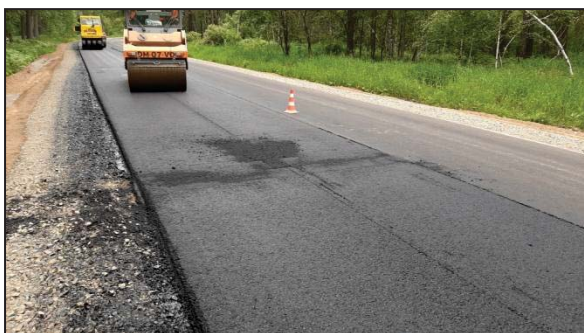
Рисунок 2 – Уплотнение защитного слоя из холодного асфальтобетона
