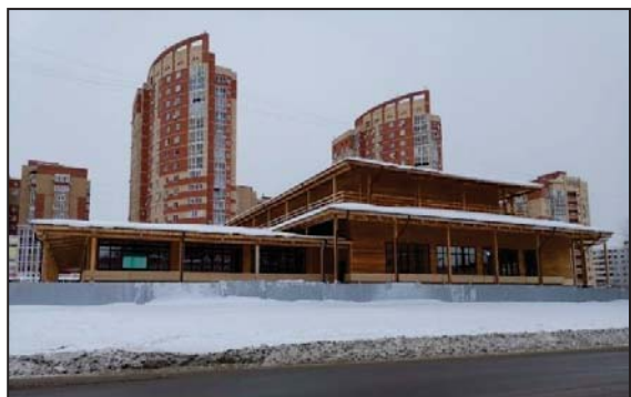
Рисунок 3 – Общий вид на здание восточных единокорпусов в г. Оренбурге
