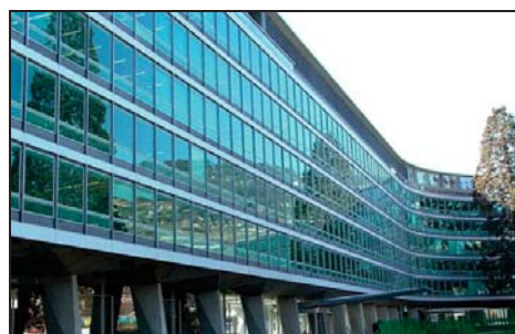
Рисунок 2 – Полное структурное остекление
