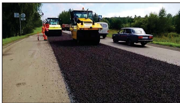
Рисунок 2 – Уплотнение поверхностной обработки
