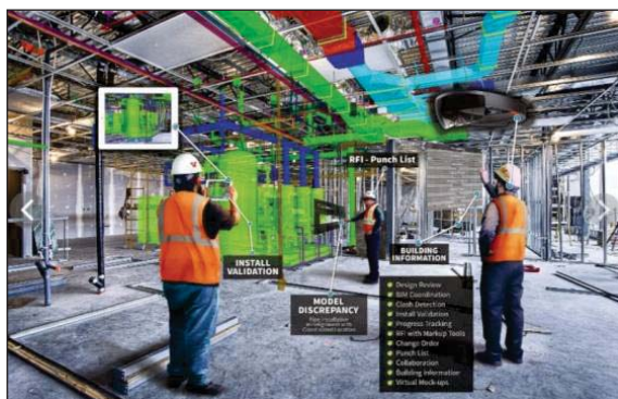
Рисунок 2 – Пример использования AR на строительной площадке
