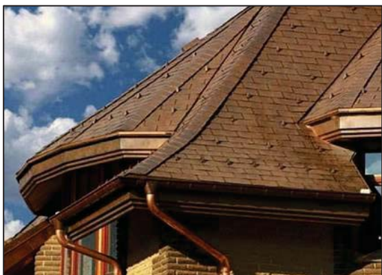
Рисунок 3 – Наружный водосток
