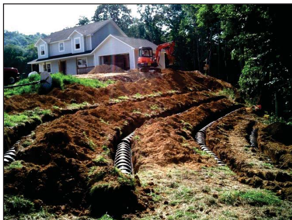
Рисунок 3 – Устройство дренажа на склоне
