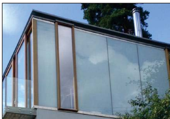
Рисунок 6 – Остекление с использованием аэрогеля в Холменколлене, Осло, Норвегия
