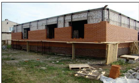
Рисунок 6 – Фасад здания в процессе устройства фасадной системы
