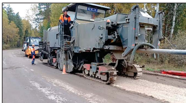
Рисунок 5 – Устройство слоя дорожной одежды методом холодного ресайклинга
