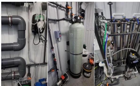
Рисунок 6 – Оборудование установки для очистки шахтных вод, установленное в блок-контейнере
