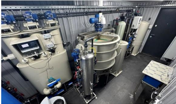
Рисунок 4 – Пилотная установка ФХО
